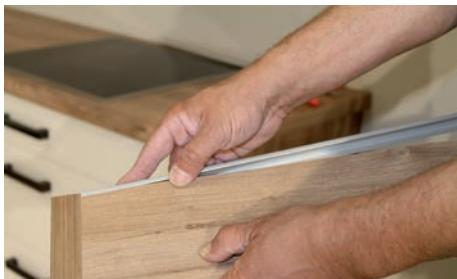
Befestigen Sie die Sockelecken und die Dichtungsrippe an die Sockelblenden auf der dem Boden zugewandten Seite.
