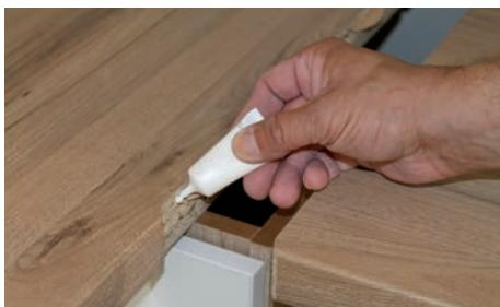
Vorstehende Späne an der Fräskante müssen mit Schleifpapier abgeschliffen werden damit die Plattenverbindung dicht wird.
