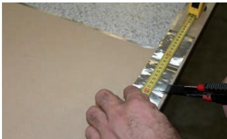
Falls dem Geschirrspüler ein Alu-Band zum Schutz der APL beiliegt, wird dieses auf der Unterseite vor dem Einbau der APL angebracht.
