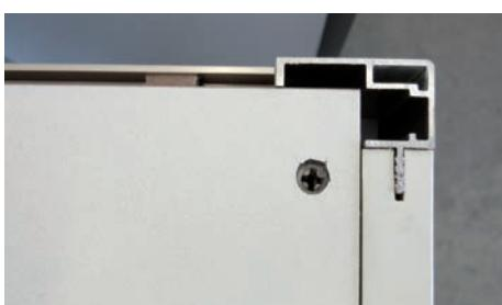
Oberboden wieder auflegen und mit den Schrauben befestigen.
