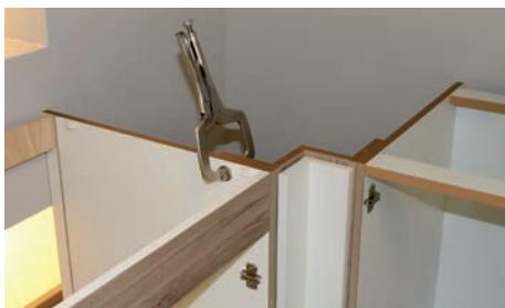
Auch hier wird der Winkel mit Hilfe von Klemmzwingen am anderen Unterschrank befestigt und ausgerichtet.
