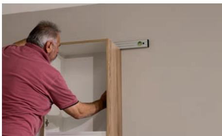
Für eine gerade Ausrichtung legen Sie eine Wasserwaage auf den Schrank und orientieren sich an der Markierung der Libelle.
