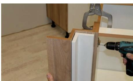
Wenn der Winkel exakt ausgerichtet ist, wird dieser mit dem Unterschrank verschraubt.
