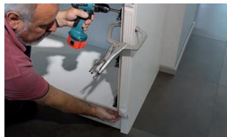
Bei Abschluss-Pilastern muss zuerst der Sockel mit dem Pilasterelement mittels Lamellos (s. Zeichnung) verbunden werden.
