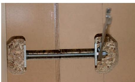
Bevor Sie den Verbinder festschrauben, überprüfen Sie die Passgenauigkeit der zusammengesetzten Platten.
