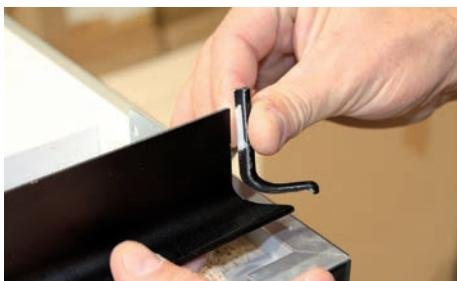
An Winkelverbindungen wird eine Innen- oder Außenecke zur Verbindung der beiden Leisten benutzt.
