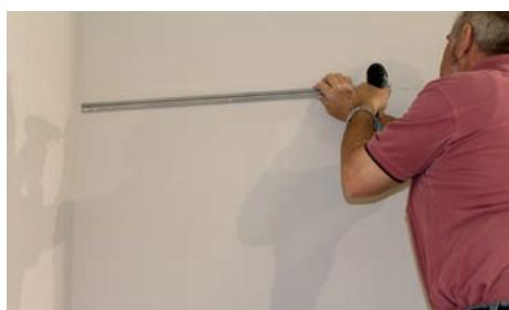
Prüfen Sie zuvor die Wandbeschaffenheit. Je nach Beschaffenheit ihrer Wand müssen die Löcher meistens mit einer Bohrmaschine vorgebohrt werden. Setzen Sie Dübel ein und schrauben Sie die Montageschienen auf die Wand. Achtung! Beim Bohren muss immer auf sämtliche Kabel und Leitungen geachtet werden!
