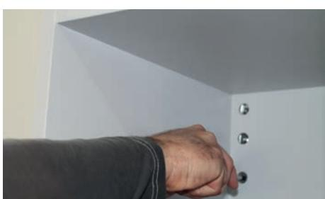
An der Oberschrankaufhängung im Inneren des Schranks kann der Oberschrank horizontal und vertikal ausgerichtet werden.
