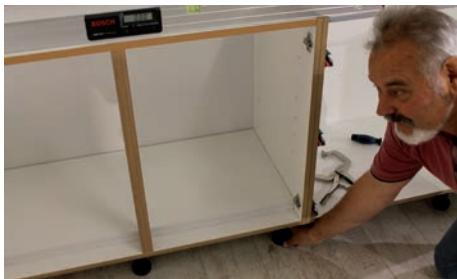
Zur Ausrichtung werden die Sockelfüße der Unterschränke in der Höhe vorne und hinten reguliert.
