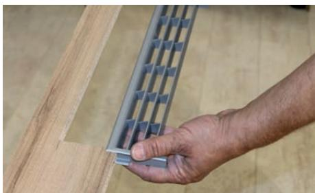
Danach wird das Lüftungsgitter von oben in den Ausschnitt eingeschoben.
