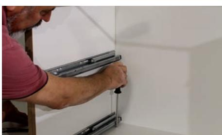
Um die hinteren Sockelfüße einzustellen, wird im hinteren Teil des Unterschränkes mit einem Schlitz-Schraubendreher die Höhe reguliert.
