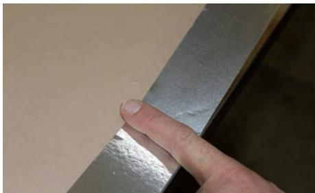
Das Alu-Band muss genau bündig an der Vorderkante der APL angebracht werden, Fugen von Kanten müssen durch das Klebeband verdeckt sein.
