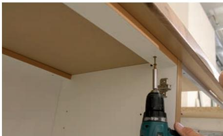
Wenn die Ausrichtung exakt erfolgt ist, kann die Arbeitsplatte an den Traversleisten, zuerst vorne dann hinten, von unten aus verschraubt werden.
