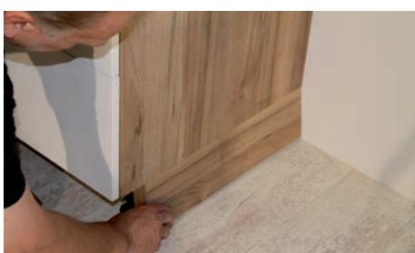
Die seitlichen Sockelblenden werden zuerst an der Oberkante schräg unter den Unterschrank geklemmt.
