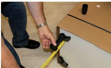
Stellen Sie vor dem Aufrichten der Schränke alle Sockelfüße auf eine einheitliche Höhe ein. Hierzu dienen kleine Pins als Markierung an den Sockelfüßen.
