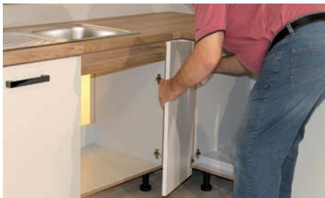
Wenn die Montage der Unterschränke und der Arbeitsplatte erfolgt ist, können die Türen eingehängt werden.
