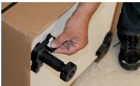
Befestigen Sie die Sockelclips durch Einschieben in den Sockelgleiter an der Vorderseite.
