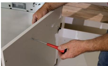
Schrauben Sie den Griff mit einem Schraubendreher von Innen nach Außen an.
