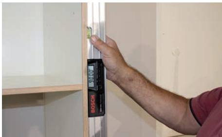
Auch die Hochschränke werden mit einer Wasserwaage gerade ausgerichtet.
