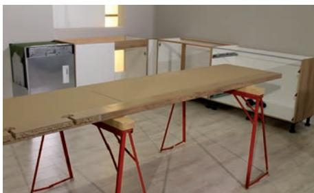
Für die Montage der Arbeitsplatte legen Sie diese für die Ausschnitte mit der Rückseite nach oben, auf eine saubere, glatte Auflage, um die Dekorseite nicht zu beschädigen.
