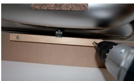
Achtung bei 25 mm Arbeitsplatten! Je nach Art der Montageklammern der Spüle, muss die mitgelieferte Montageleiste bei der Verschraubung verwendet werden.
