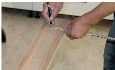
Die Sockelblende muss zuerst in der Länge und in der Höhe passend auf die entsprechenden Maße geschnitten werden.
