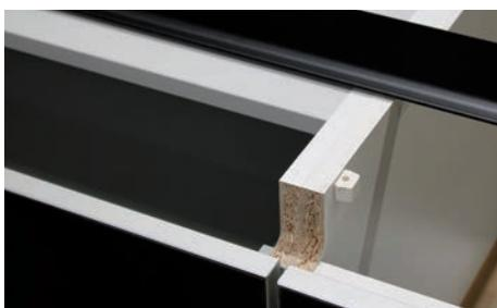
Bei einer grifflosen Küche muss eine spezielle Griffleiste angebracht werden. Sobald die Schränke fertig ausgerichtet und verschraubt sind, muss vor der Montage der Arbeitsplatte, das Anbringen der Griffleiste erfolgen.
