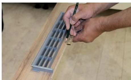
Unter E-Geräten mit Be-/Entlüftung hinter dem Hochschränk muss ein Lüftungsgitter in der Sockelblende mittig unter dem Gerät montiert werden. Dieses wird bündig an der oberen Kante der Sockelblende angelegt, um den Ausschnitt anzulegen. Mögliche Abdeckplatten auf solchen Geräteschränken müssen ebenfalls mit einem Lüftungsgitter versehen werden.
