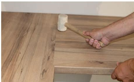
Setzen Sie die Arbeitsplatteneckverbinder an der Unterseite der Platte in die vorgefrästen Aussparungen ein und ziehen diese leicht an. Falls die Kanten nicht exakt bündig voreinander liegen, können Sie vorsichtig einen Gummihammer verwenden. Benutzen Sie dazu für den Schlagplatz eine Massivholzleiste als Unterlage.
