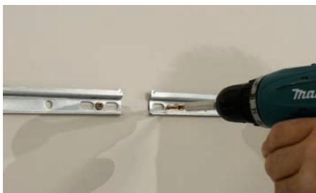
Das mitgelieferte Material ist nur für feste, massive Wände geeignet. Das mitgelieferte Montagematerial ist nicht geeignet für Porenbeton-, Gipskarton- und Holzwerkstoffwände.
