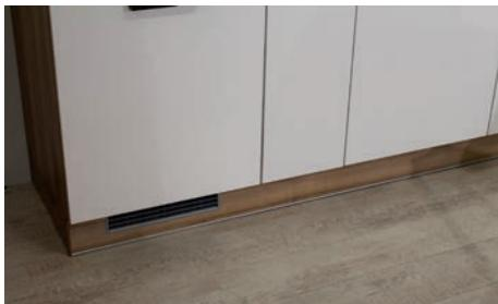
Nun kann die Sockelblende an der vorderen Seite zuerst schräg an der oberen Kante unterhalb der Sockelklammer eingeklemmt und dann gerade an den Sockelfuß herangedrückt werden.
