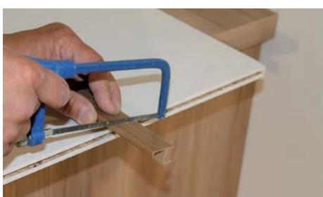
Die Sockelecken müssen nun mit einer kleinen Säge (Puksäge) auf das angezeichnete Maß gekürzt werden.
