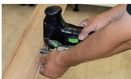
Anschließend schneiden Sie vorsichtig den Ausschnitt mit einer Stichsäge aus.
