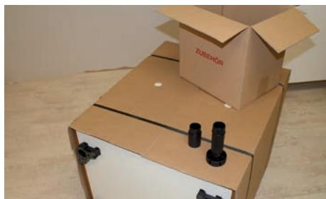
Zuerst legen Sie die Unter- und Hochschränke vorsichtig auf die Rückseite, ohne die Verpackung zu entfernen, damit Kratzern und Beschädigungen vorgebeugt wird.
