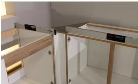
Wenn der Eckpasswinkel mit den anliegenden Unterschränken verschraubt wurde, müssen alle übrigen Unterteile millimetergenau ausgerichtet werden.
