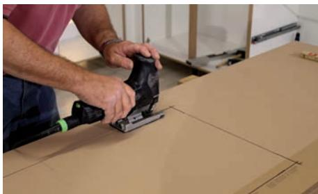
Die feineren Gehrungen in den Ecken werden mit einer Stichsäge ausgeschnitten.
