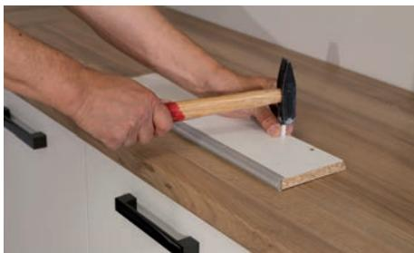
An den seitlichen Sockelblenden werden die beigefügten Kunststoffdübel in den mittleren Bohrungen befestigt.
