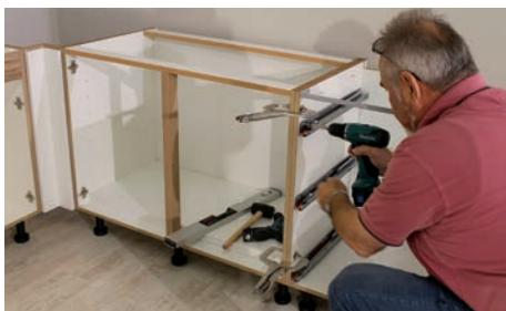
Wenn die Ausrichtung der Schränke genau erfolgt ist, können die Möbelteile mit Klemmzwingen zusammengehalten und miteinander verschraubt werden.
