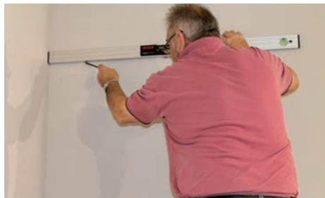
Danach wird eine gerade Linie auf der entsprechenden Höhe gezogen. Nehmen Sie eine Wasserwaage zur Hilfe.
